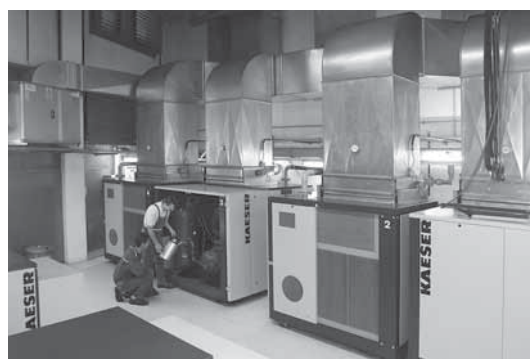
Rys. 5 - Przegląd konserwacyjny systemu sprężonego powietrza w zakładach Porsche (Copyright Druckluft Effizient)
